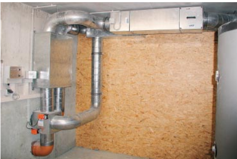
Kompakte Lüftungszentrale im Keller: einfaches Stecksystem mit Wärmetauscher, Pufferspeicher und Anschluss an Erdwärmetauscher
